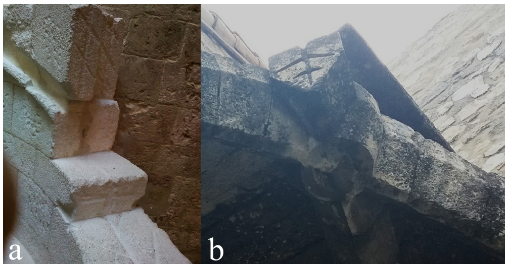
09 Habarcstapadást segítő vájatok a montmajouri bencés kolostorban és a Villeneuve-les-Avignon-i karthauzi kolostorban
