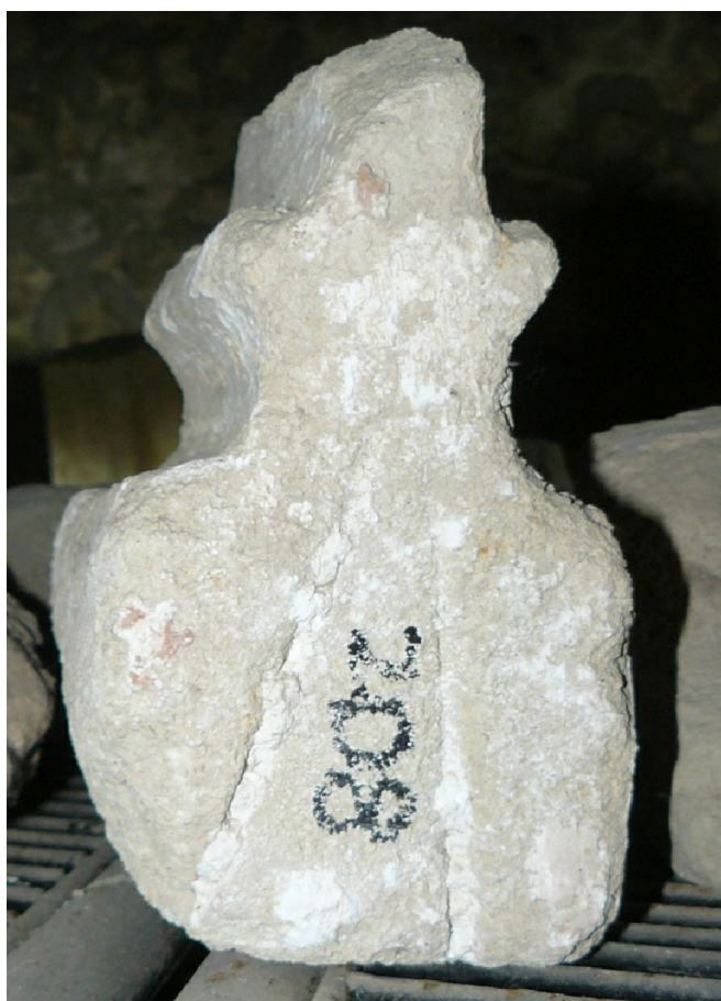
08 Habarcstapadást segítő vájatok a zsámbéki kőtár egyik késő gótikus boltozati bordaelemén, katalógusszám: 208
