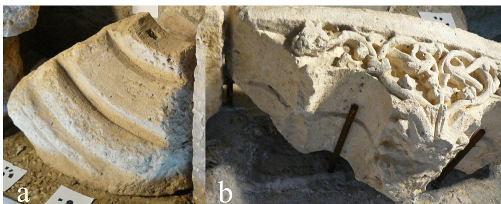
11 Ablakkeretek a zsámbéki kőtárból csatlakozó szerkezetek számára kialakított vájatokkal: a) a főszentély ablakkerete rács számára kialakított lyukkal, b) valószínűleg a kolostorkerengő ablakainak köve üveg számára kialakított horonnyal, katalógusszám: 89, 98(?)
