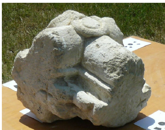
13 „+” alakú technológiai jel a zsámbéki kőtár valószínűleg egykor boltozatot alkotó köelemén, katalógusszám: 33
