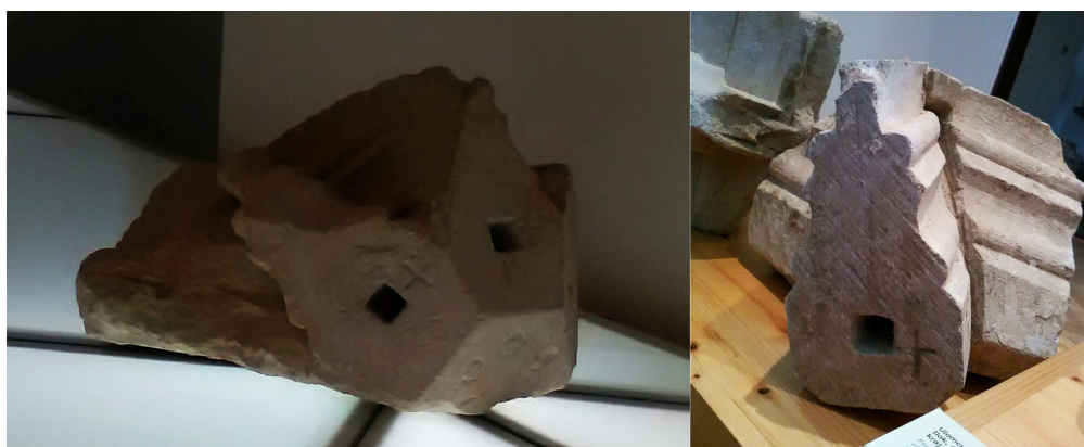
10 Késő gótikus bordacsomópontok az újlaki Városi Múzeumban (Ilok, Horvátország)
