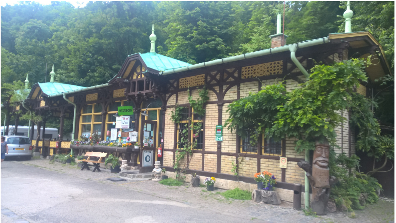
13 Az épület homlokzata északkeleti irányból.
