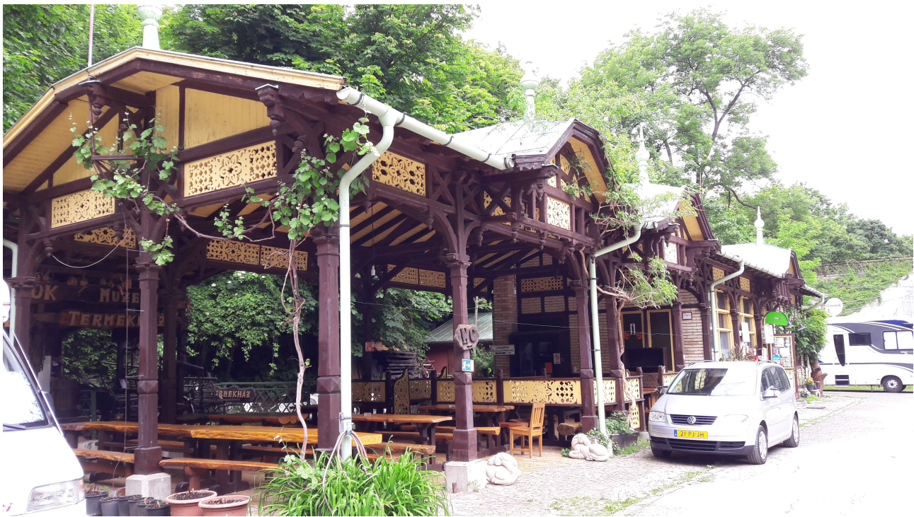
14 Az épület homlokzata délkeleti irányból.
